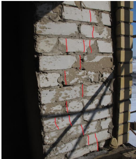
2 сурет - Жарықтардың арасы a_{сгс}=0,01...0,2 мм, кірпіштің 11 қалау төсеміндегі (1 кіреберіс)
