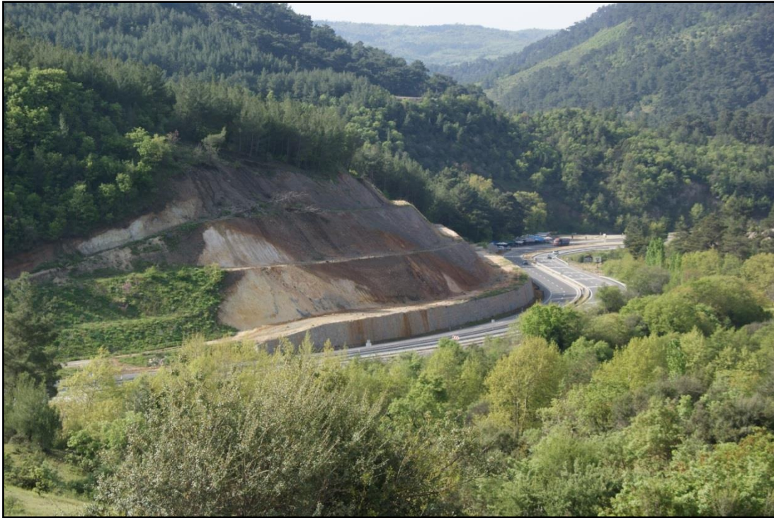
Foto 4: Balıkesir – Edremit Karayolu 62. km'sinde yamaç dengesini korumak amacıyla yapılan teraslamanın görünümü (2015).
