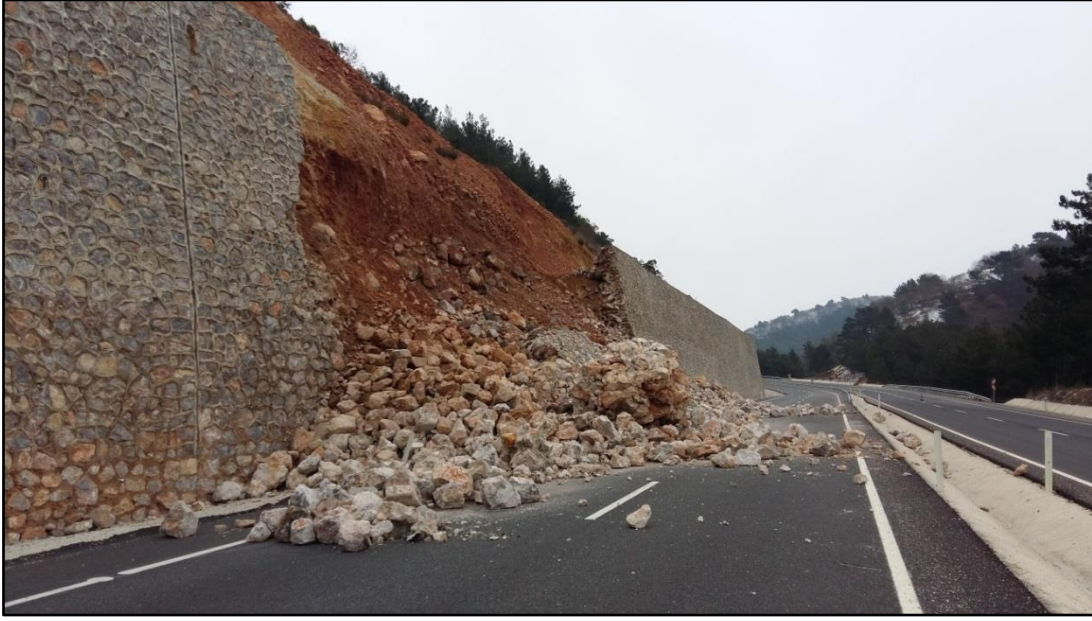
Foto 3: Yamaç dengesinin bozulması sonucunda büyük miktarda malzeme istinat duvarını yıkarak yola taşmıştır. Bitki örtüsünün tahrip edilmesi de bunda önemli rol oynamaktadır (Balıkesir – Edremit Karayolu 60. Km, 2015).
